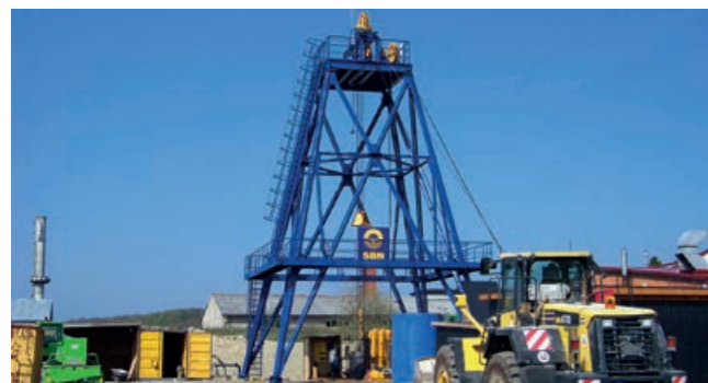
Schachtverwahrung Schächte Hüpstedt/Beberstedt
