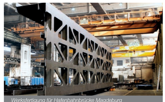
Werkstofffertigung für Hafenbahnbrücke Magdeburg
