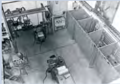
Erste ortsfeste Ausbildungsstätte im VEB Schachtbau Nordhausen für E-, G- und MAG-CO 2 -Schweißen 1978
