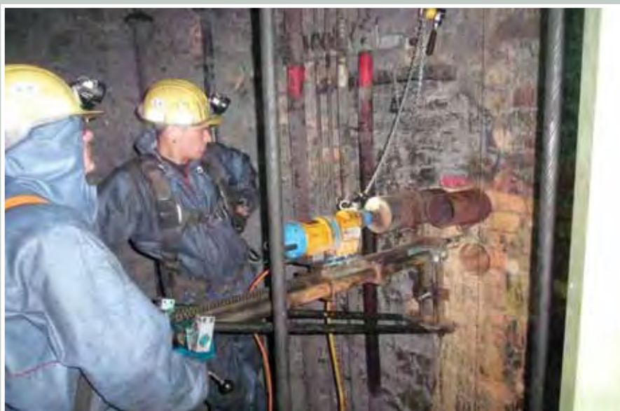
Kernbohrungen im Schachtmauerwerk
