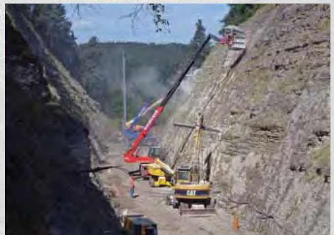
Bohrarbeiten mit 4 Bohreinheiten
