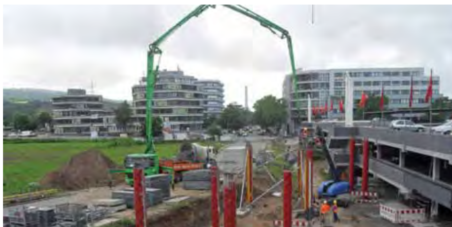
Betonage Pfeiler der neuen Brücke
