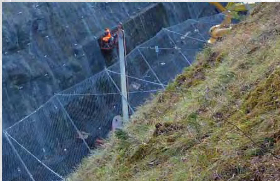
Detail Konstruktion Auffangschürze
