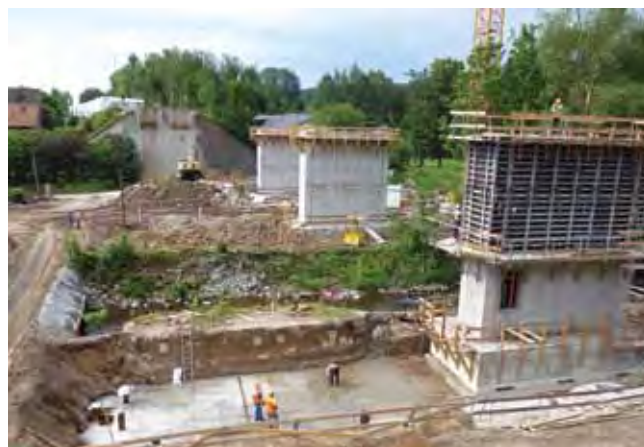
Herstellung der Verschiebbahn
