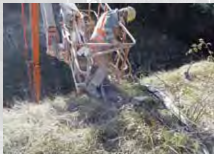
Ralf Lehm beim Einbau der Seilanker
