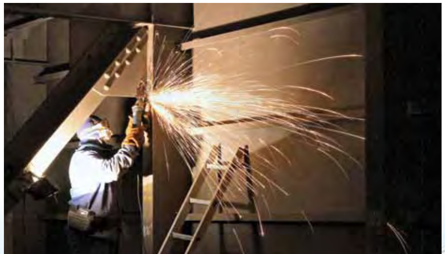
Maik Rullert beim Sanieren gerissener Schweißnähte
