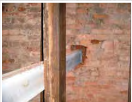
Montage neue Einstriche in Bühnenlöcher
