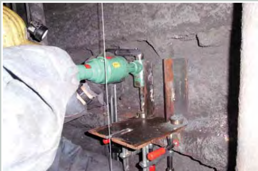
Bohrungen im Tübbing
