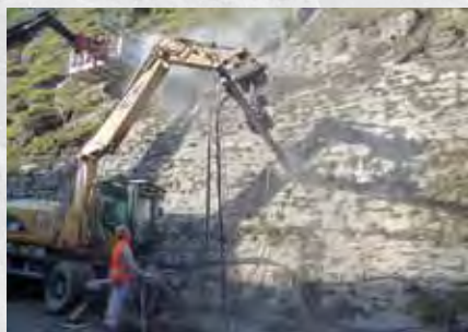
Sebastian Bogner mit Bohrbagger
