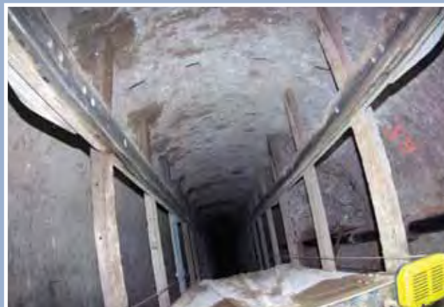
Blick in die Schachtröhre Röhrigschacht
