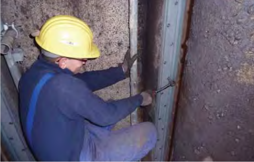
Schleuse Serrig: Einbau der neuen Laufschienen von Thomas Lendewig
