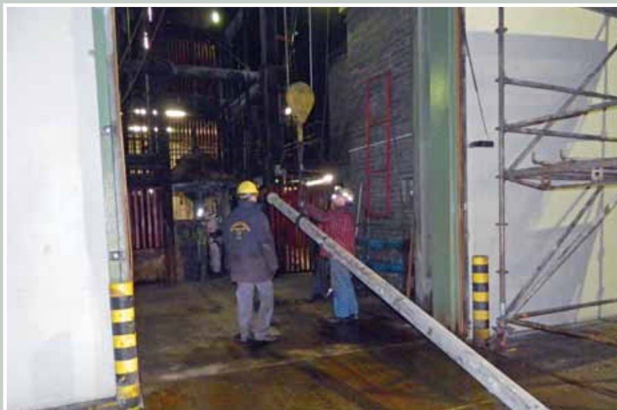
Transport der 6 metrigen Schachtrohre
