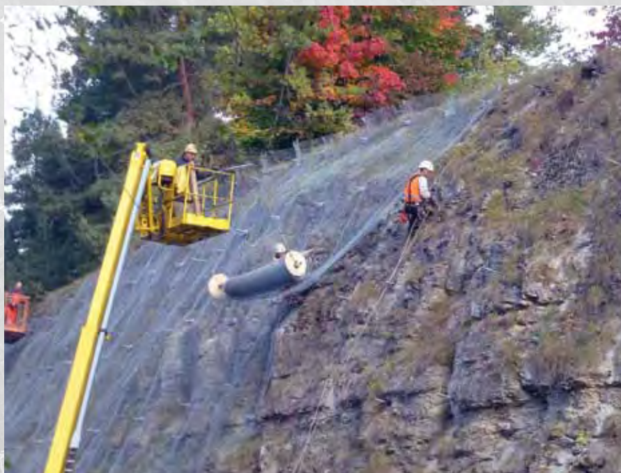
Verlegearbeiten des Netzes in 25 m Höhe
