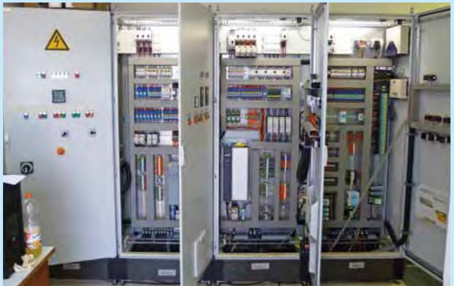
Aufstellung und Inbetriebnahme der NHV auf der Baustelle
