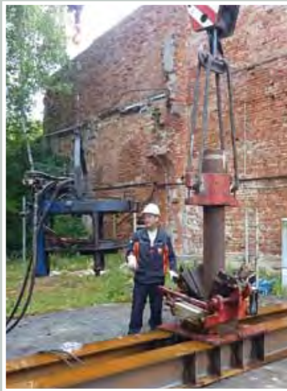
Montage der API-Rohrleitung
