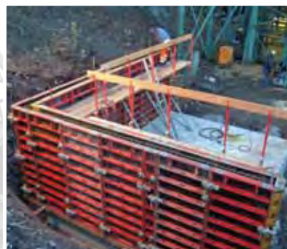
Betonage Haspelhaus Hilfsfahranlage
