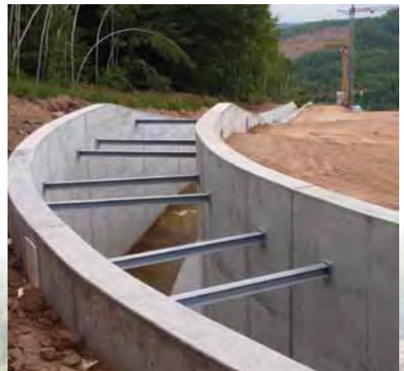
Teil des Zulaufbauwerkes mit Aussteifungsträgern
