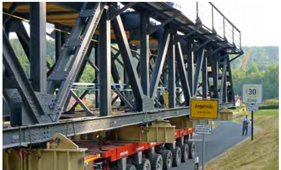
Transport eines Überbaus mit SPMT zur Einbaustelle
