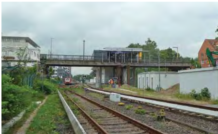
Ansicht alte Holzbrücke
