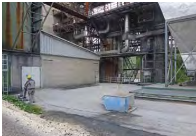
Marian Bischlepp bei Fräsarbeiten an der Betondachfläche
