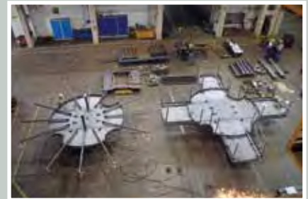
Fertigung Arbeitsbühne Schacht Neubleicherode im Stahlbau SBN
