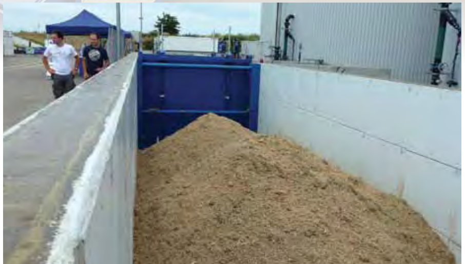
Bild 2: Feststoffdosierer Multifloor - unterirdische Aufstellung
