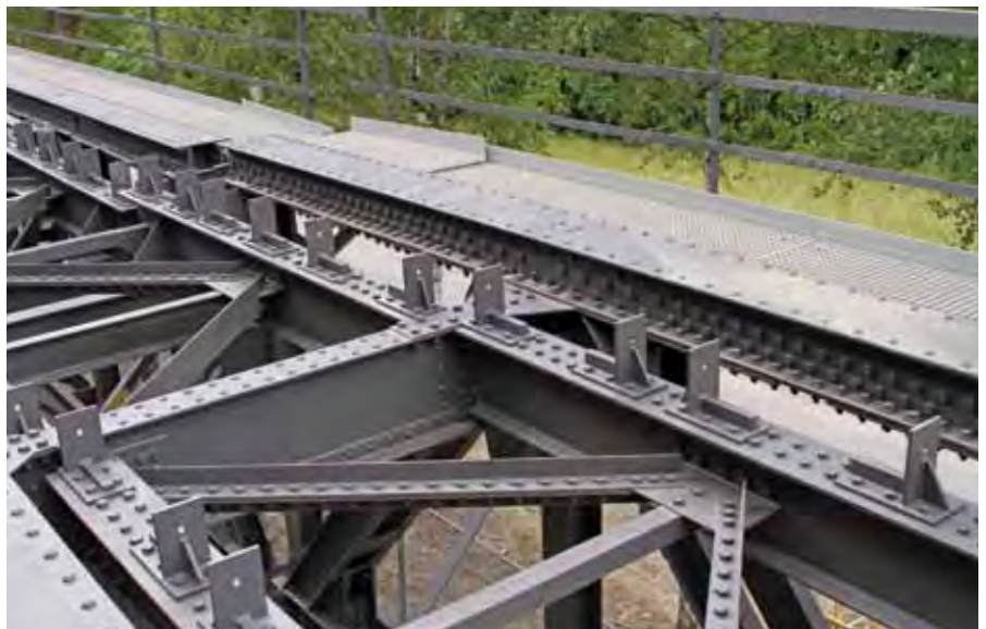
Schraubverbindungen am Schlingerverband sowie an Haupt- und Längsträgern
