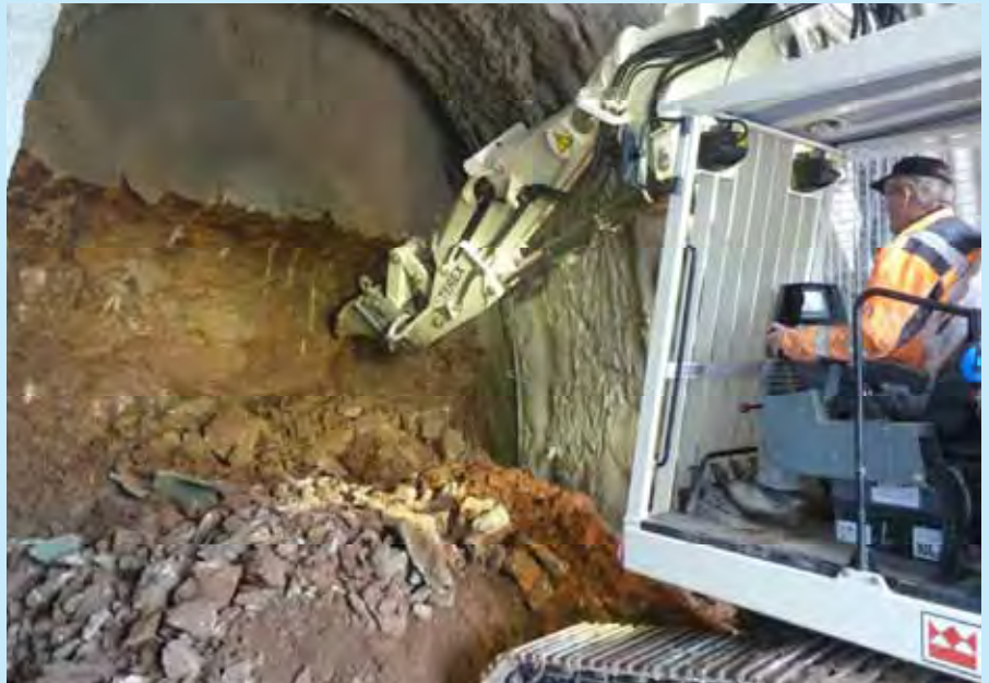
Mechanisches Lösen/Vortrieb im Portalbereich mittels Tunnelbagger
