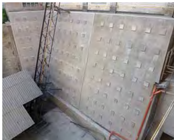
Fertige Stützwand mit angrenzenden Anlagen
