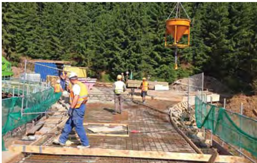
Betonage Gefällebeton auf der Massivmauer
