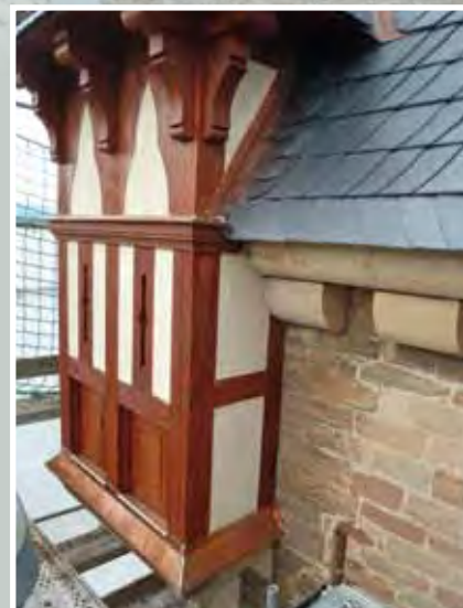
Fachwerk nach der Sanierung
