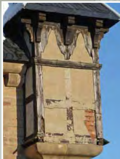
Fachwerk vor der Sanierung
