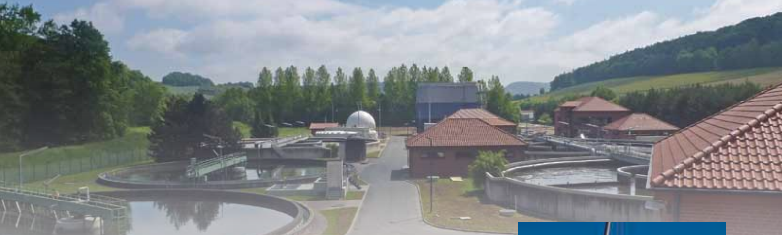
Blick über die Belebungs- und Nachklärbecken in Richtung Faulungsanlage
