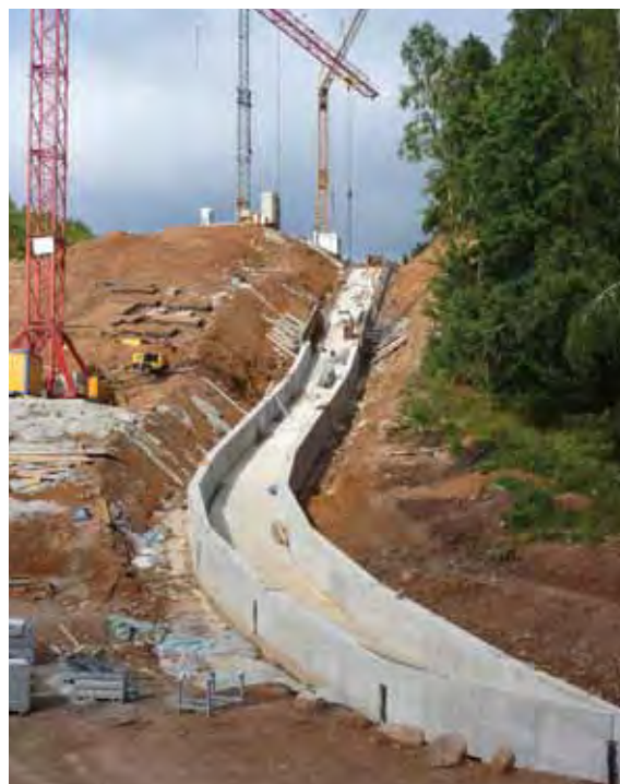
Schalarbeiten an der Schussrinne bei 38% Neigung
