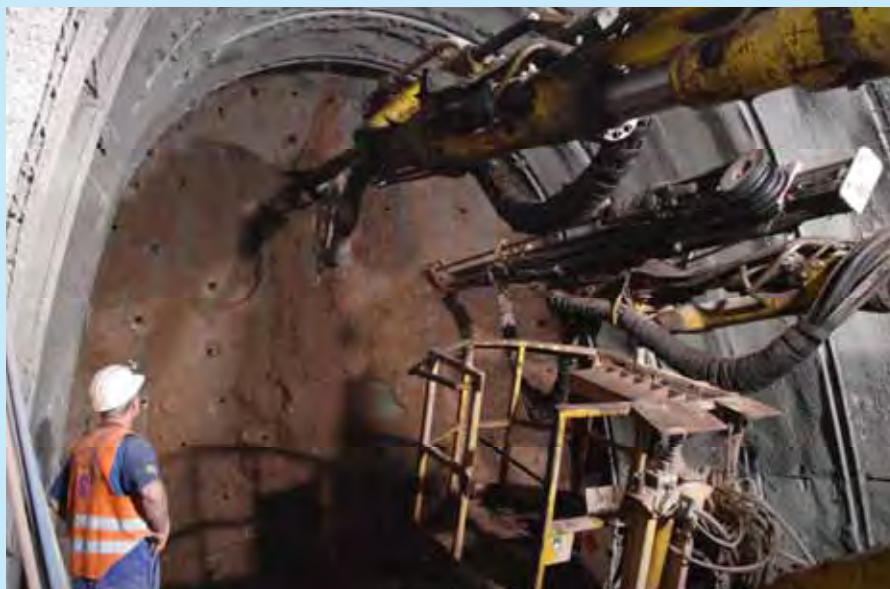
Olaf Netolicky beim Bohren der Sprengbohrlöcher
