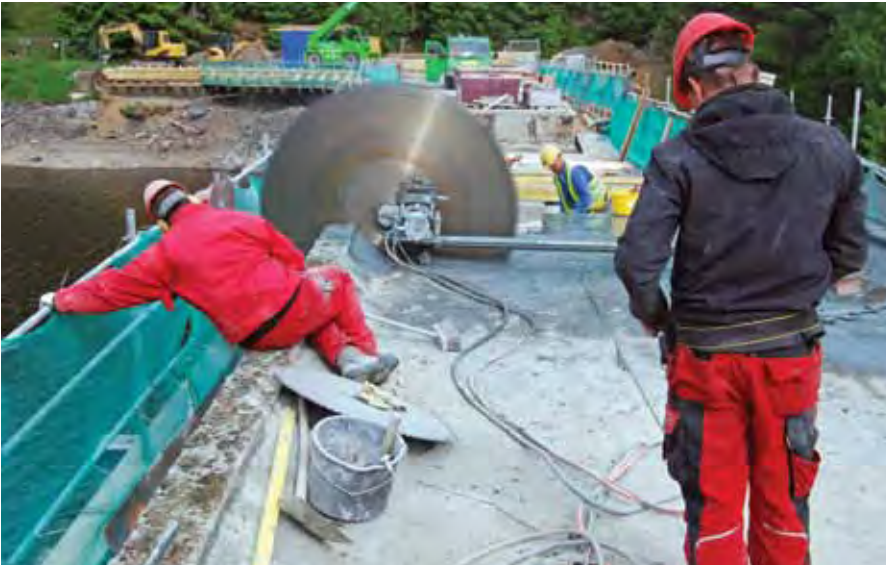
Betonsägearbeiten
