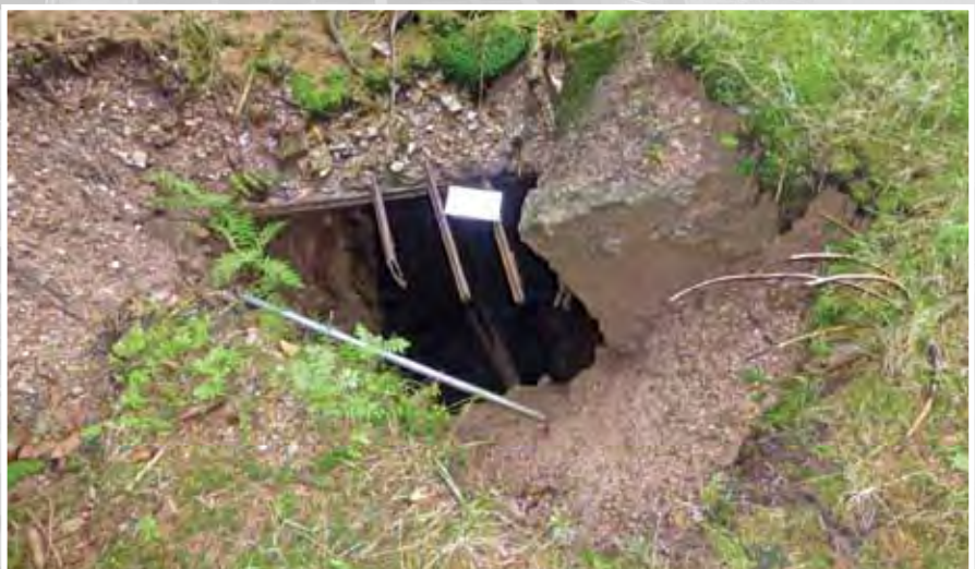
Ungesicherter Tagebruchtrichter
