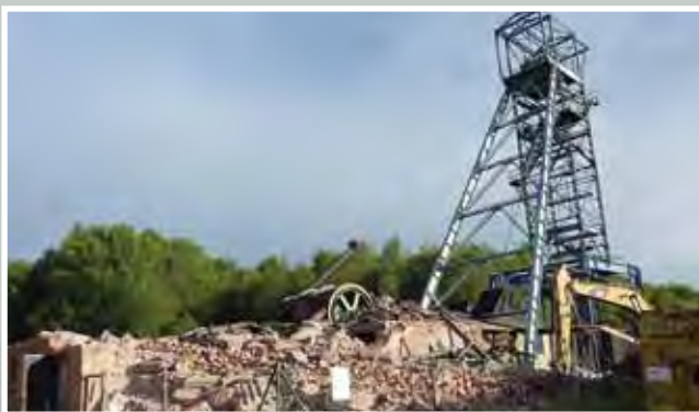
Schacht Neubleicherode – Abbrucharbeiten vorhandenes Fördermaschinenhaus; das Schachtgerüst wird für die Verwahrungsarbeiten genutzt
