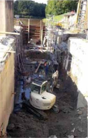
*Blick in die Schleusenkammer; im Vordergrund laufende Abbrucharbeiten; im Hintergrund Vorbereitung Verankerung und Bewehrungsarbeiten*
