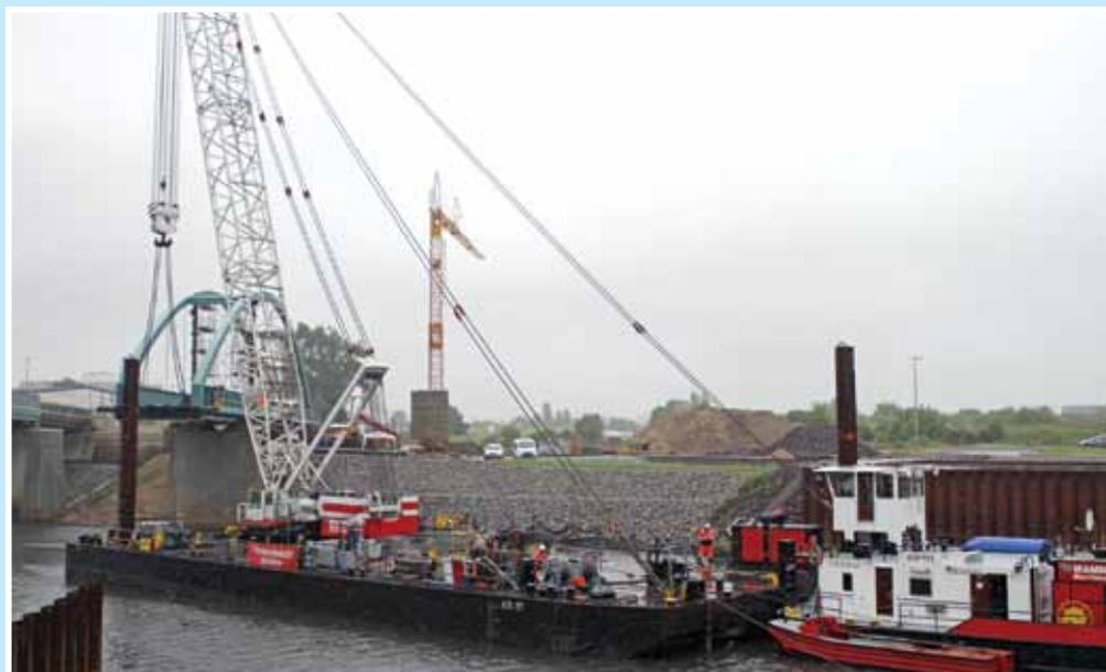
Schwimmkran wird für die letzte Phase des Einschubvorganges angeschlagen
