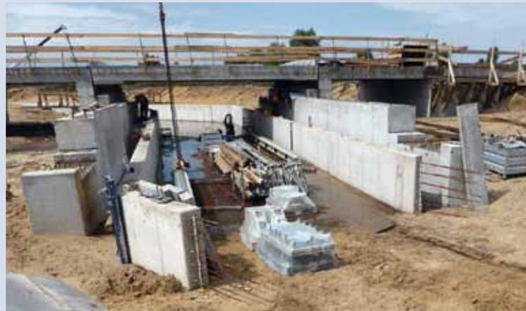
„Flugplatzbrücke“ - Mitarbeiter Maschinenbau bei Vorbereitungen zur Montage der Verschiebeeinrichtungen
