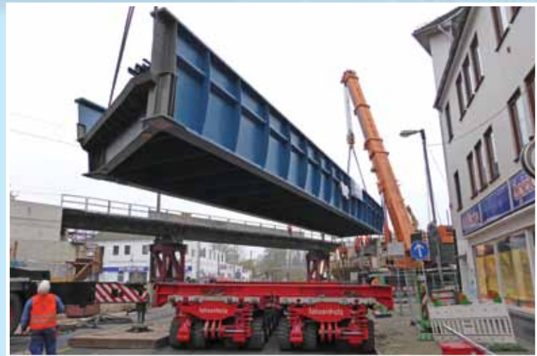
Einhub Überbau West
