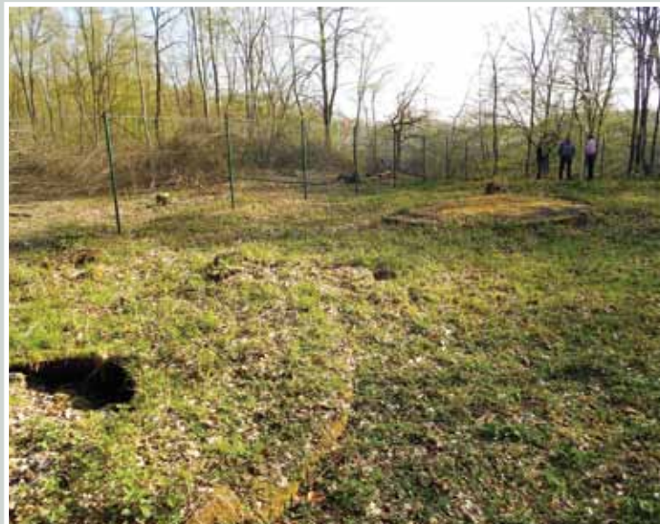
Situation Moselschacht vor Beginn der Sicherungsarbeiten
