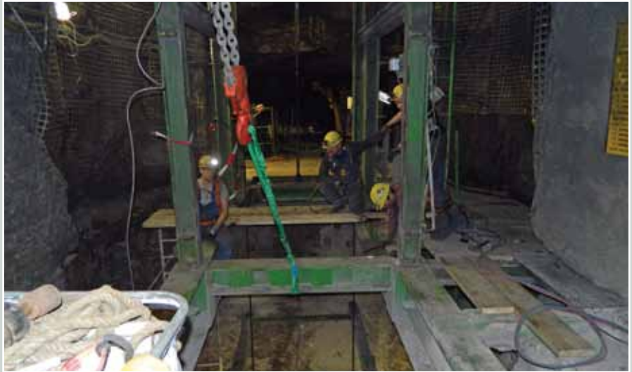
Arbeiten im Füllortbereich
