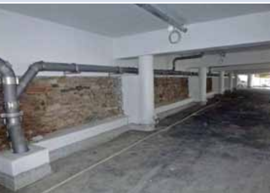
Freideckunterseite nach Oberflächenschutz und neuer Entwässerungssammelleitung
