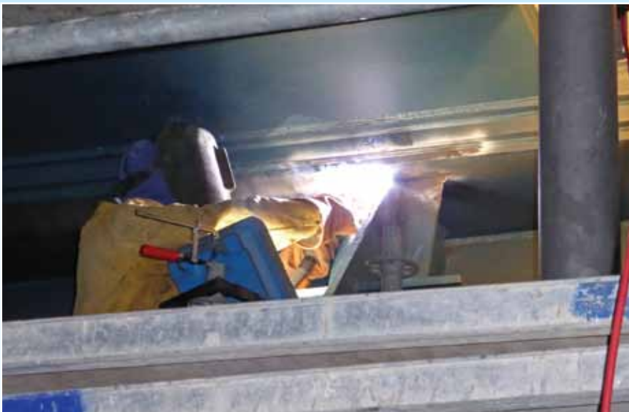
Dietmar Serb bei Schweißarbeiten am QT-Anschluss
