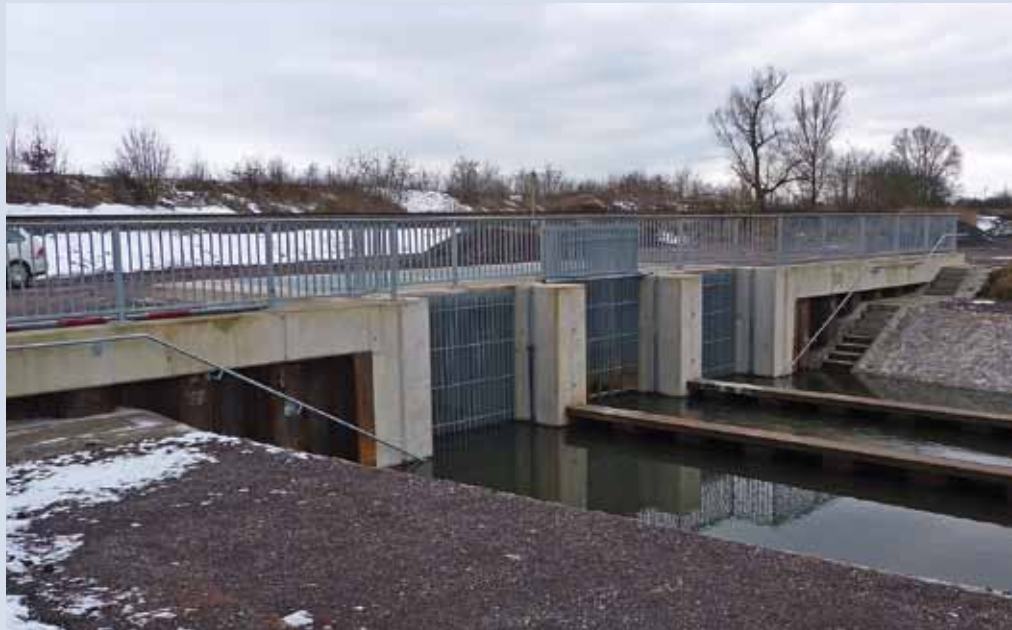
Einlaufbauwerk nach Fertigstellung
