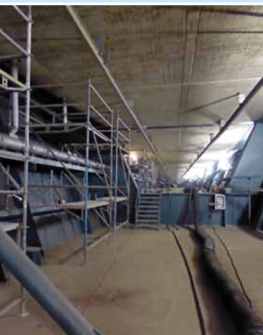
Baustelleneinrichtung im Hohlkasten unter der Fahrbahn
