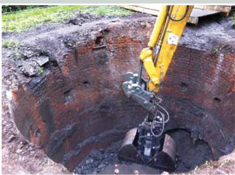
Arbeiten im Moselschacht
