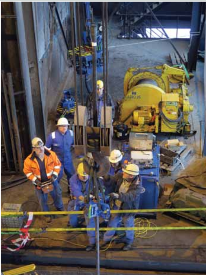
Montage der Rohrleitung
