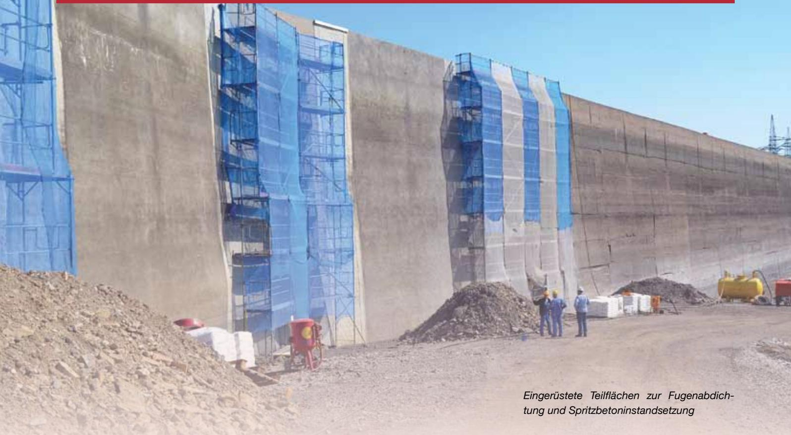
*Eingerüstete Teilflächen zur Fugenabdichtung und Spritzbetoninstandsetzung*
