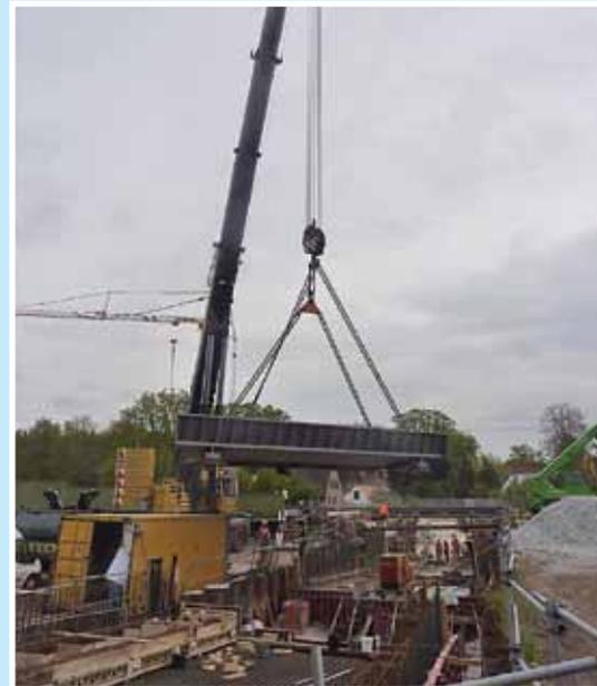
Einbau Brücke im 1.BA mit 400 t Mobilkran
