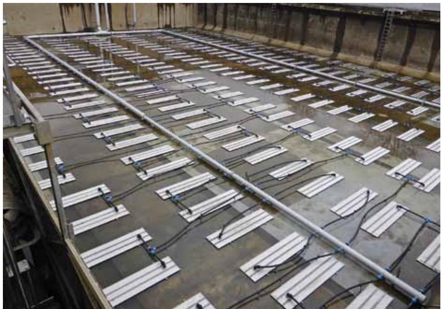
*Belebungsbecken 1, Kaskade 1.5 – Fertiggestellte erneuerte Belüftung mit RMU-Plattenbelüftern*
