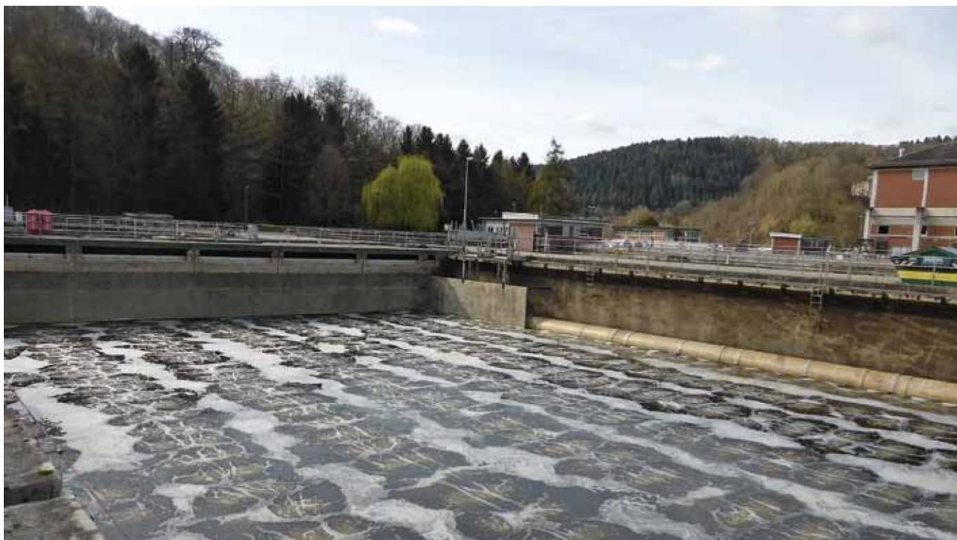
*Funktionstest (Blasentest) der neu montieren Platten vor der Wiederinbetriebnahme bzw. Beckenfüllung*
