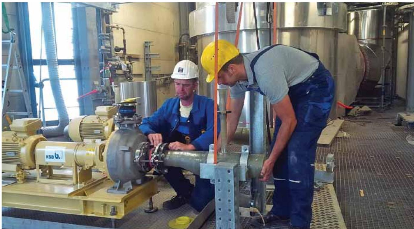
Polier Ronny Hagenbruch und Monteur Mathias Schuller bei Montagearbeiten an den sogenannten Boosterpumpen Wäscher 3
