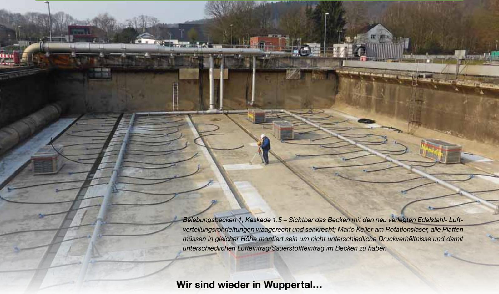
*Belebungsbecken 1, Kaskade 1.5 – Sichtbar das Becken mit den neu verlegten Edelstahl- Luftverteilungsrohrleitungen waagrecht und senkrecht; Mario Keller am Rotationslaser, alle Platten müssen in gleicher Höhe montiert sein um nicht unterschiedliche Druckverhältnisse und damit unterschiedlichen Lufteintrag/Sauerstoffeintrag im Becken zu haben*
