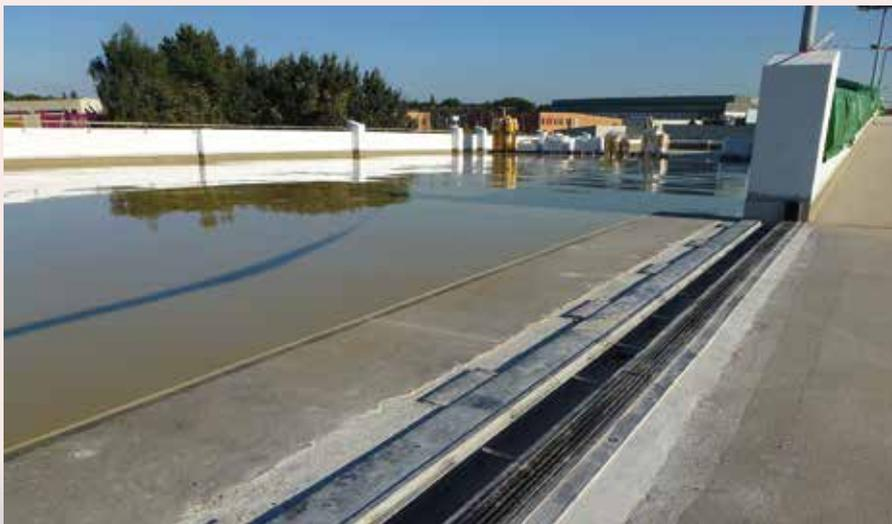
*Freideckebenen mit Fugen-Rinnenkonstruktion und verschiedenen Beschichtungslagen OS 11*
