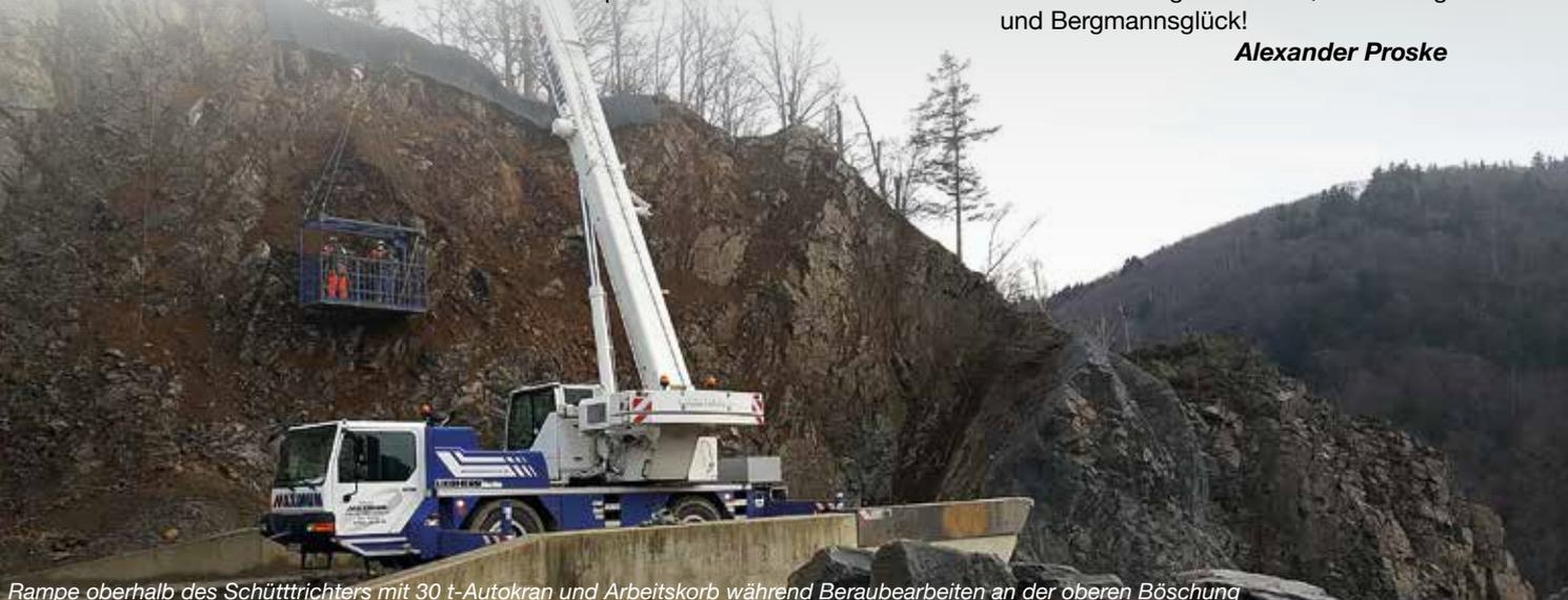
*Rampe oberhalb des Schüttrichters mit 30 t-Autokran und Arbeitskorb während Beraubearbeiten an der oberen Böschung*
