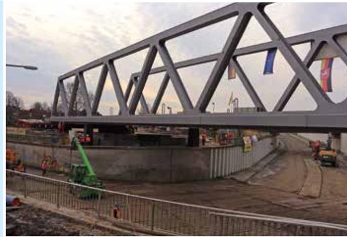
Einfahren Überbau, Sicht von Widerlager Achse 20
