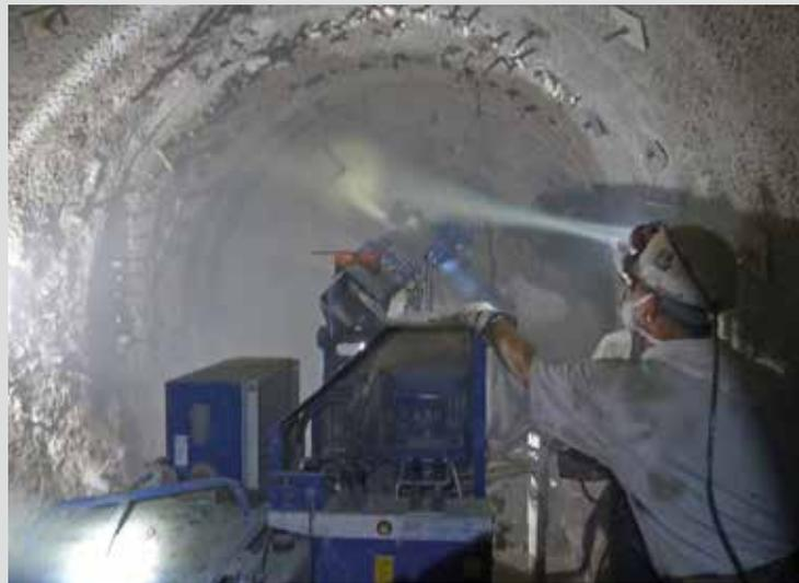
Einbau von Spritzbeton zur Streckensicherung
