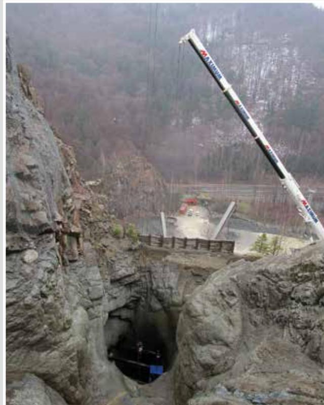
Schachtkopf mit bereits eingebauten Stahlträgern und sich anschließendes Tagebaugelände; im Hintergrund die B4
