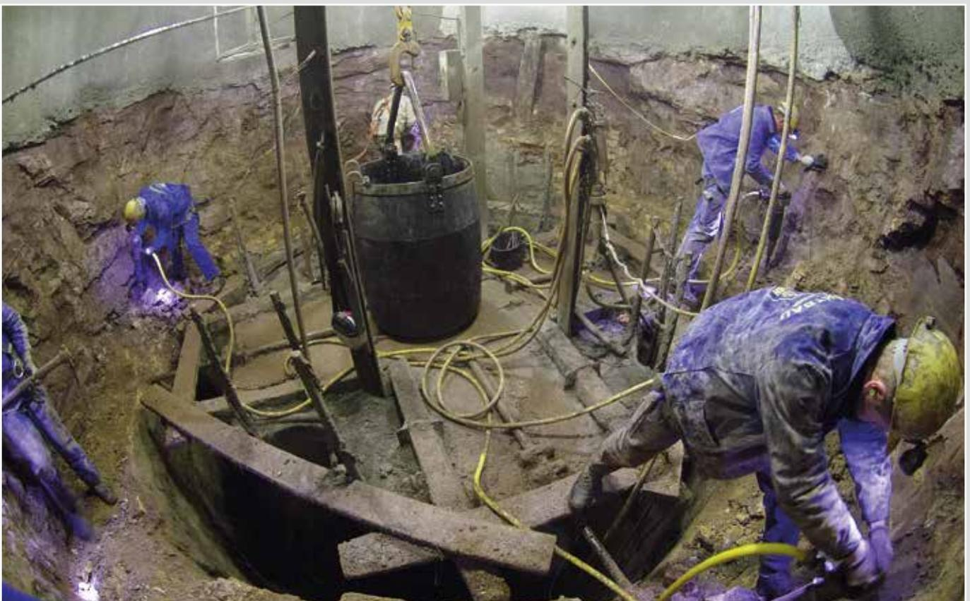
Ausbruch entfestigtes Schachtmauerwerk von Hand
