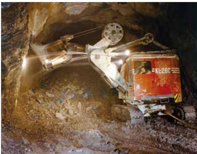
Pumpspeicherkraftwerk Markersbach, Elektrotunnelbagger Landsverk KL260, Auffahrung Hilfsstollen 1972
