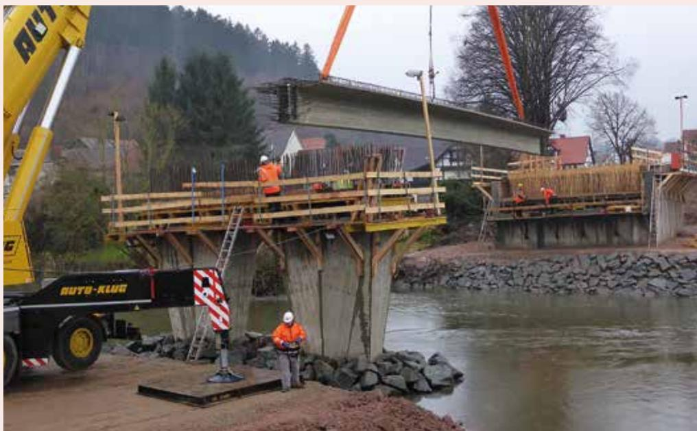
Die Kollegen des Teams um Polier Dirk Grabert bei der Montage der 24 m langen Betonfertigteil-Überbauträger
