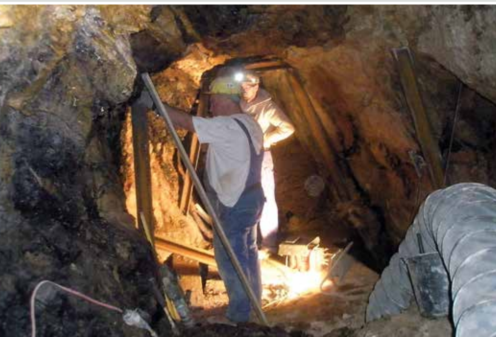
Sicherungsarbeiten an der Kippstelle der Zwischensohle, Steffen Leopold und Lutz Baldauf
