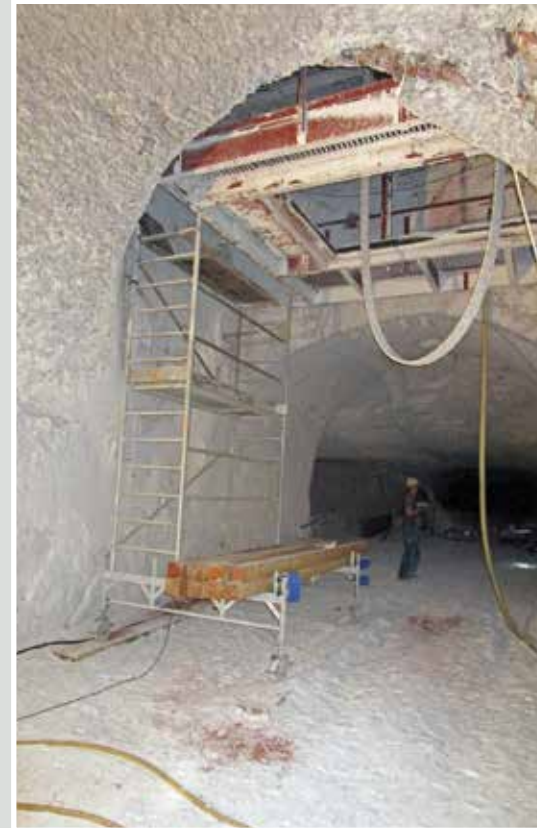
Sumpfsohlenbereich mit Arbeitsgerüst und Buchholzbühne
