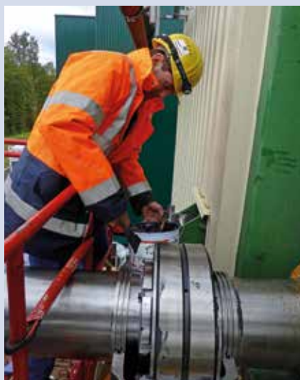
Ralf Köthe bei der Montage der Antriebseinheit auf der Baustelle in Frankreich
