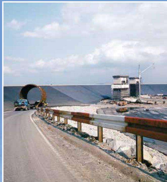
Damals 1977: Antransport des letzten Rohrschusses der Panzerung zum Einbau in die Triebwasserleitung (Pumpspeicherkraftwerk Markersbach - Diaserie von Walter Rudolph Serie Triebwasserleitung Panzerung Notiz auf Diarahmen: "Letzter Schuß, 9/77" 09/1977
