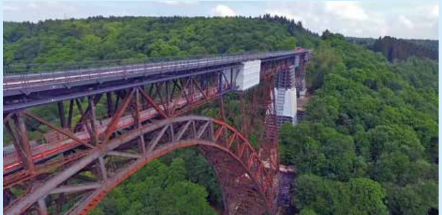
Ansicht Abschnitte der Einhausungen in der Gerüstbrücke und Pfeiler VI
