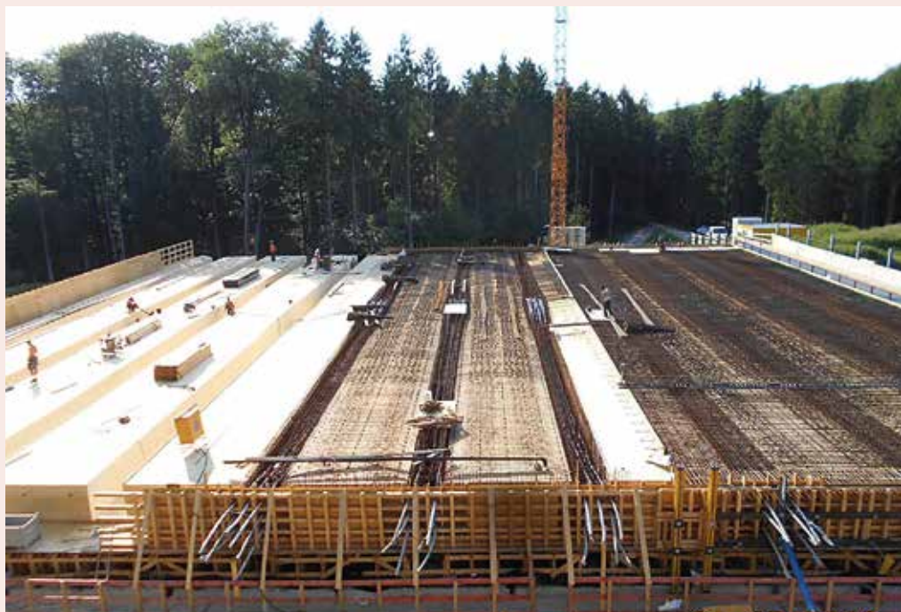
Ansicht nach Traggerüstausbau
