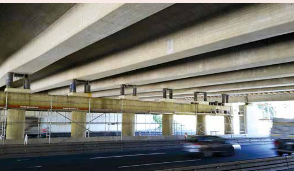
Blickrichtung: Widerlager Achse A zu Achse Mittelpfeiler
