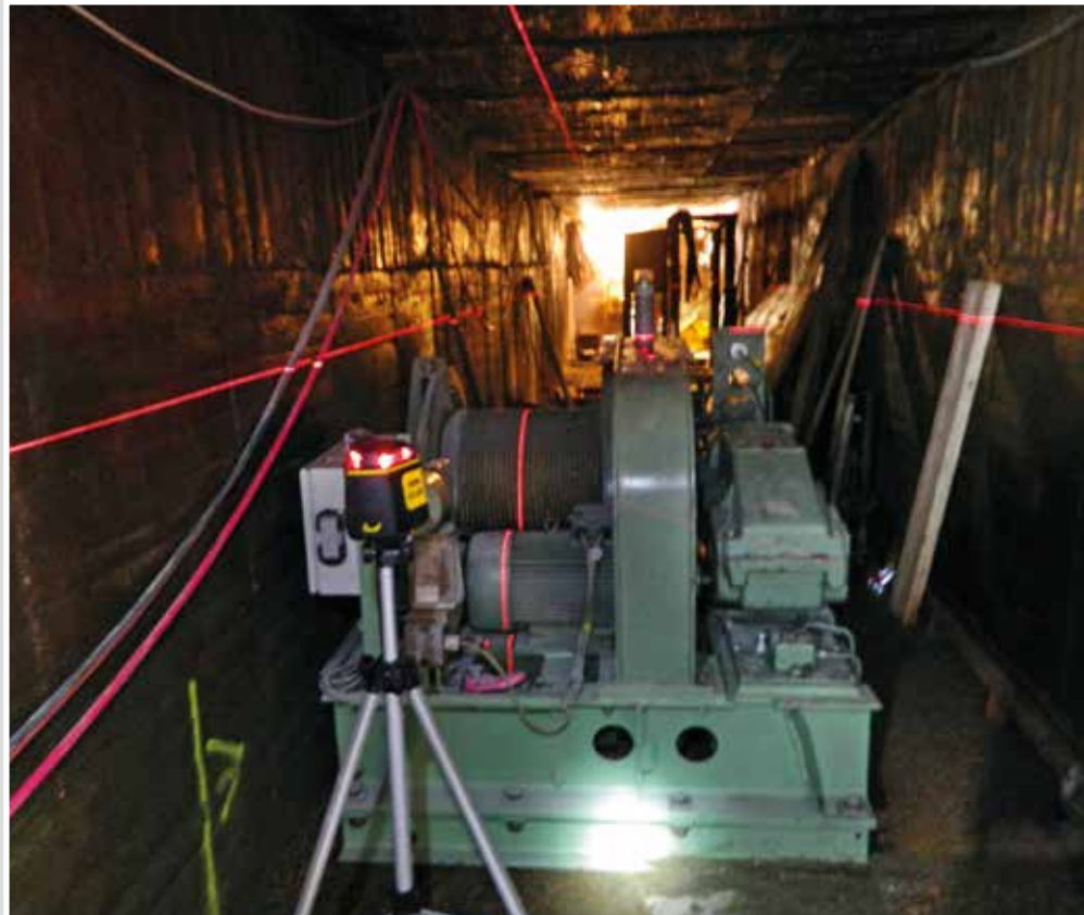
Ausrichten und Aufstellen der Winde unter beengten Verhältnissen unter Tage
