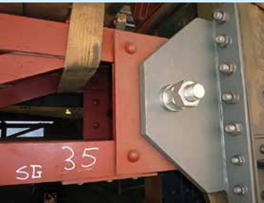
Detail Ertüchtigung Gelenk Untergurtstab in der Gerüstbrücke
