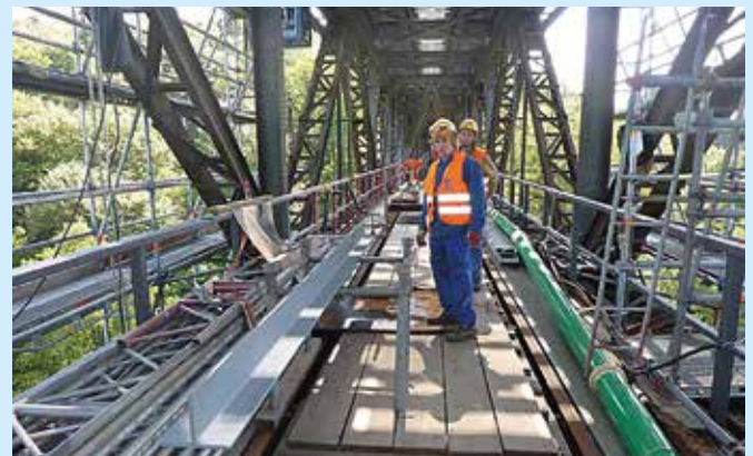
Moritz Wiemann und Mario Gräber beim Vorbereiten der Profile für den H-Verband
