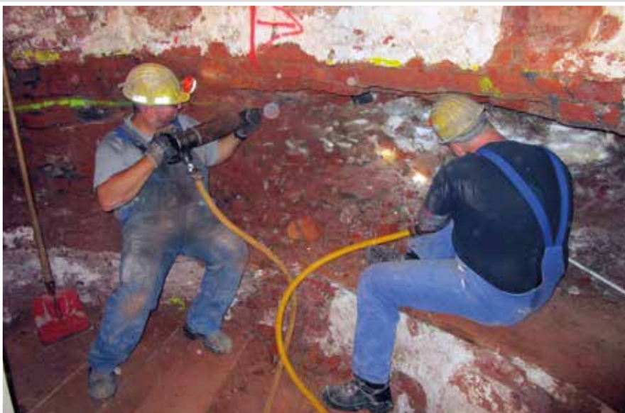
Jan Ungefroren und Michael Götz während des Abbruchs des Mauerwerkes im Bereich des geplanten Tragringes
