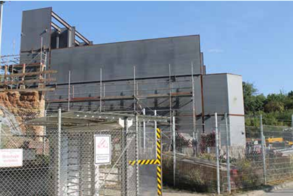
Ansicht von Südost: Kaskade I komplett und die Hälfte der Kaskade II
