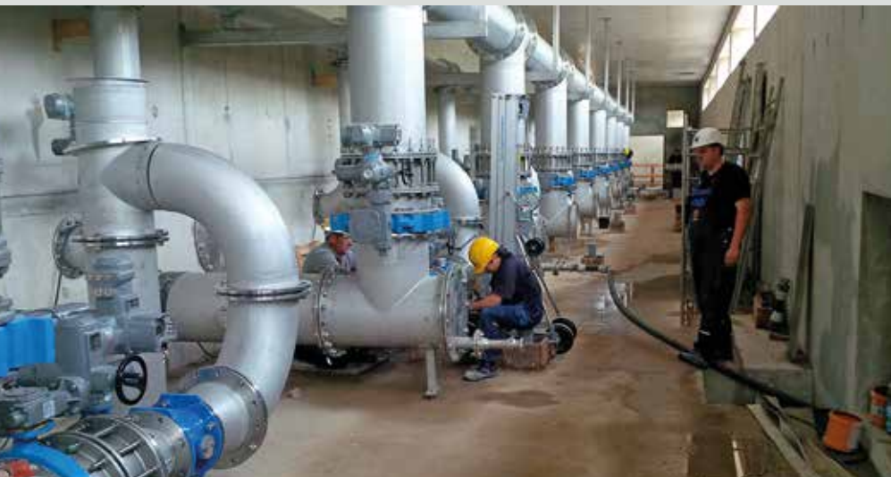
Montagen im Filterbediengang (v. l. n. r.) Oliver Papst, Thomas Käller, Enrico Stöhr
