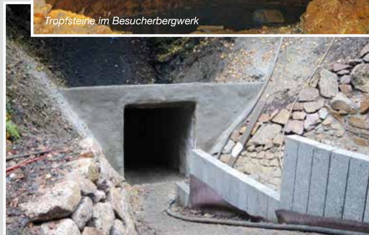
Neu gestaltetes Mundloch mit Übergang zum Tosbecken
