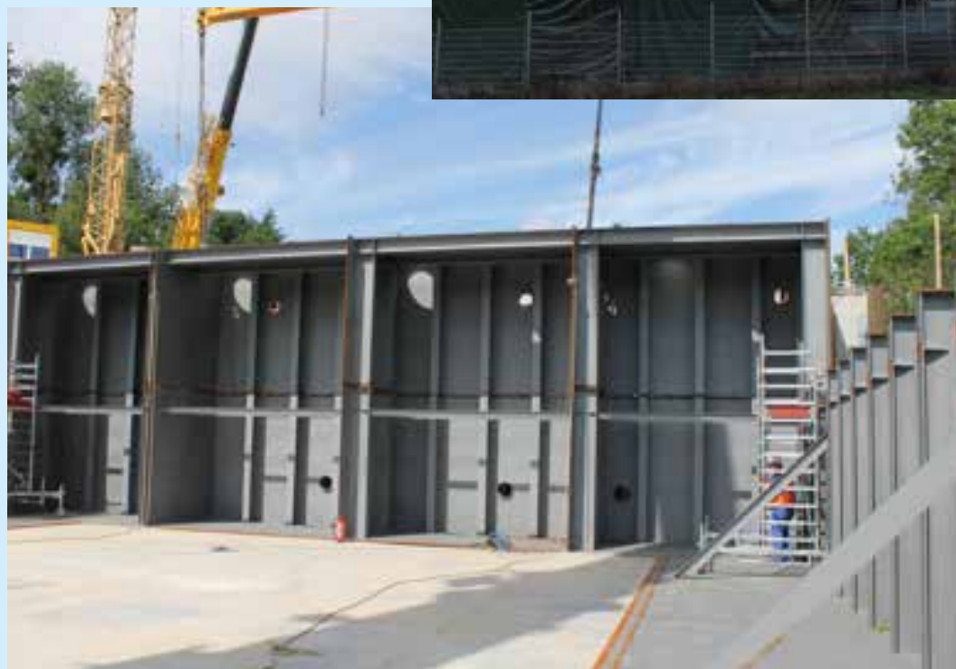
Hochzeit der unteren mit der oberen Baugruppe
