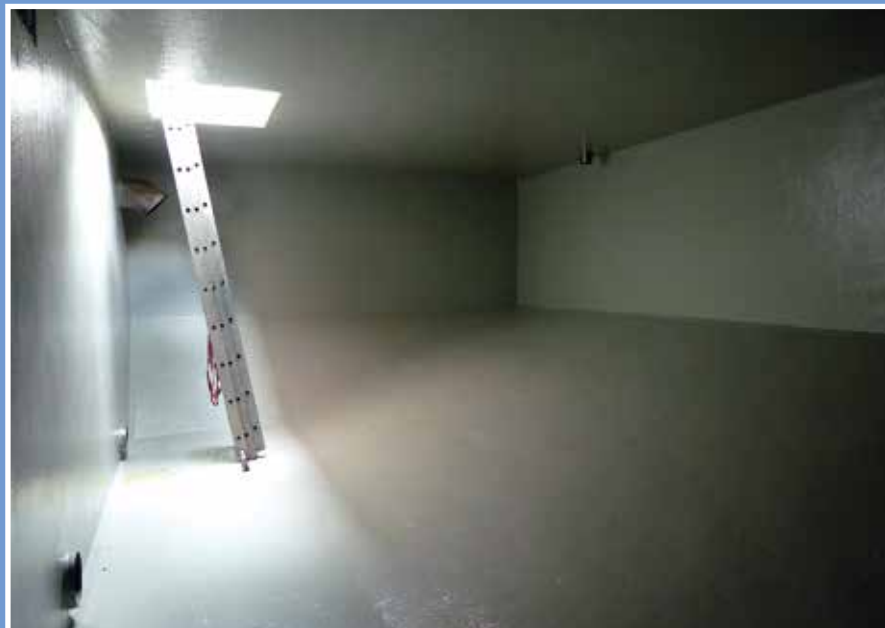
Überschussschlammvorlagebehälter nach der BSK-Beschichtung
