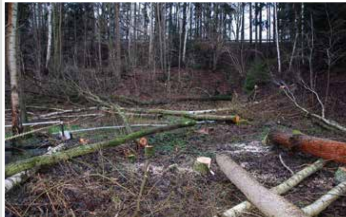
Baufeldfreimachung vor Beginn der Baumaßnahme
