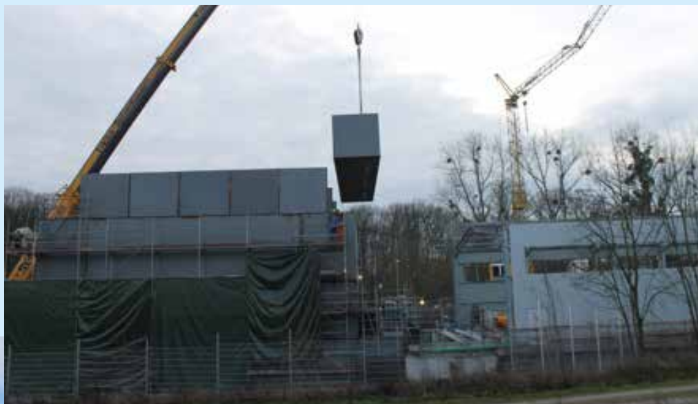
Letztes Bauteil für den Probenahmebehälter
