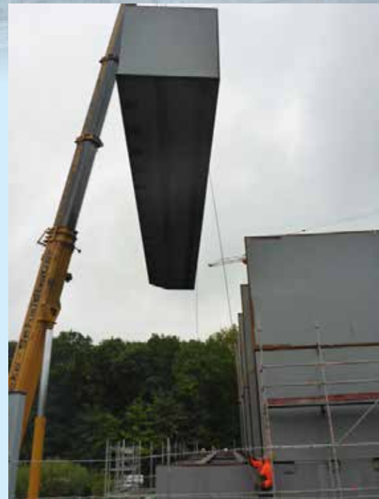
Einheben des vorletzten Bauteils von Kaskade II
