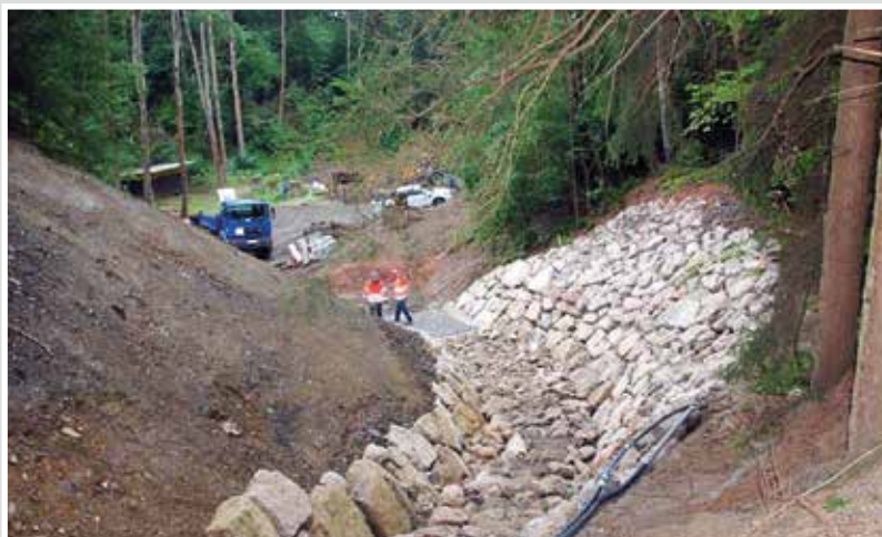
Gelber Graben neu ausgebaut (Ansicht von oben)
