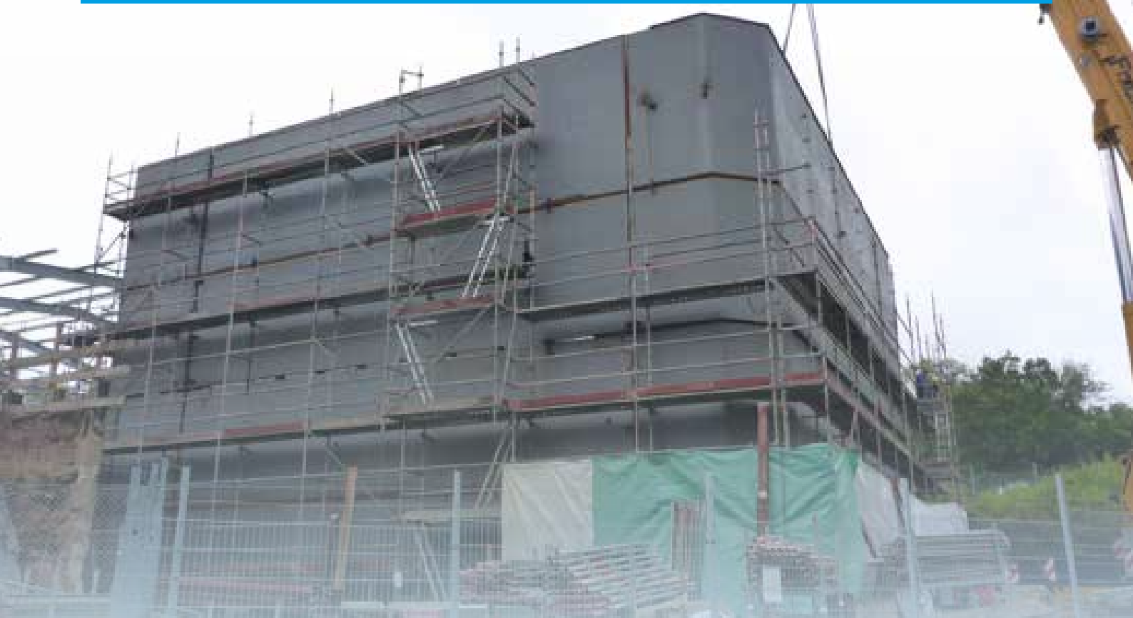
Flachbodentank nach Auflegen der letzten Baugruppe von Kaskade II
