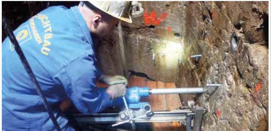
Kevin Bernsdorf beim Herstellen von Kernbohrungen mit einem Durchmesser von 50 Millimetern
