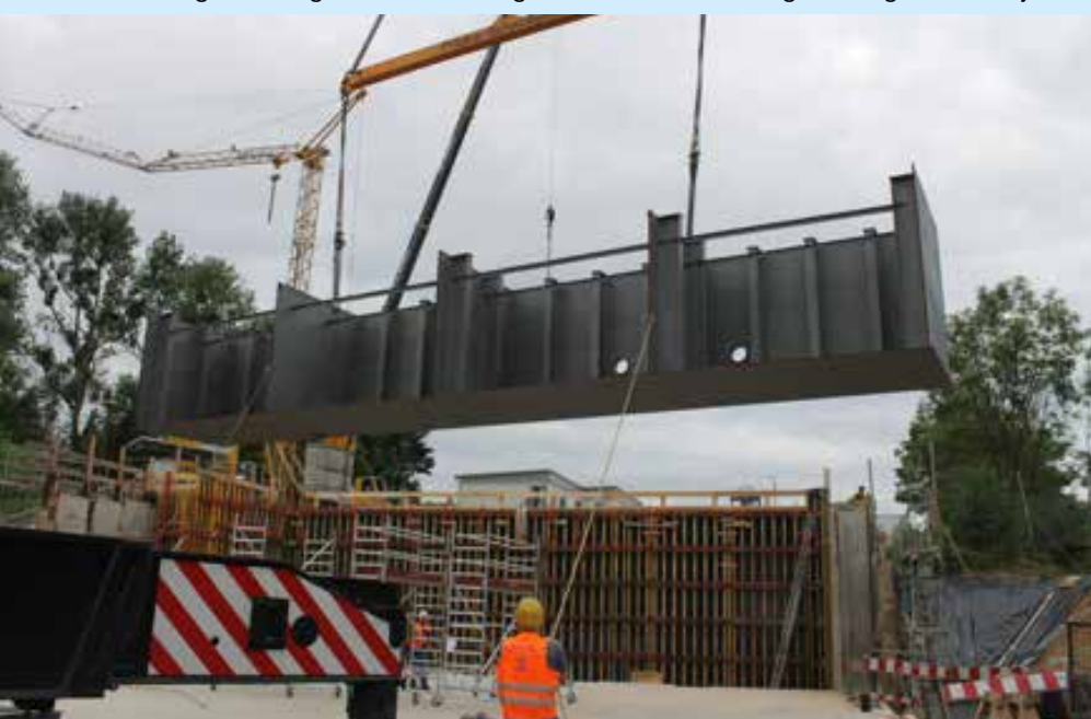
Baugruppe 1 der Kaskade I wird positioniert
