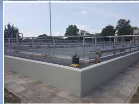
Außenwand und Gehweg
