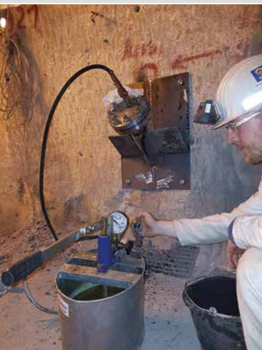
Christian Köhler (Betriebsführer) bei der Durchführung und Dokumentation der Druckprobe Betonförderleitung DN 100 PN 64 mit 100 bar
