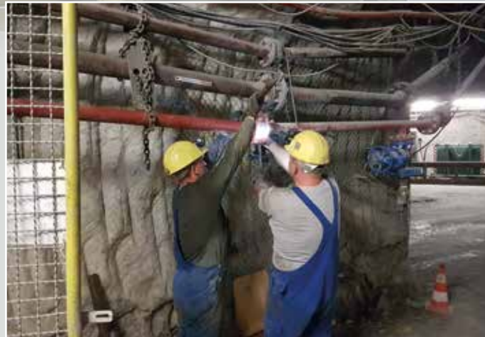
Uwe Meynberg (links) und Frank Leopold bei der Montage einer Druckleitung DN 65 PN 100
