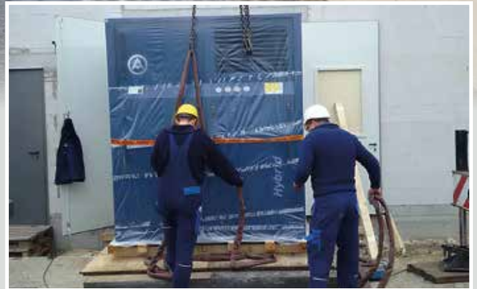
Mathias Schuller (links) und Steffen Klimm bringen passgenau den Verdichter in das Gebäude
