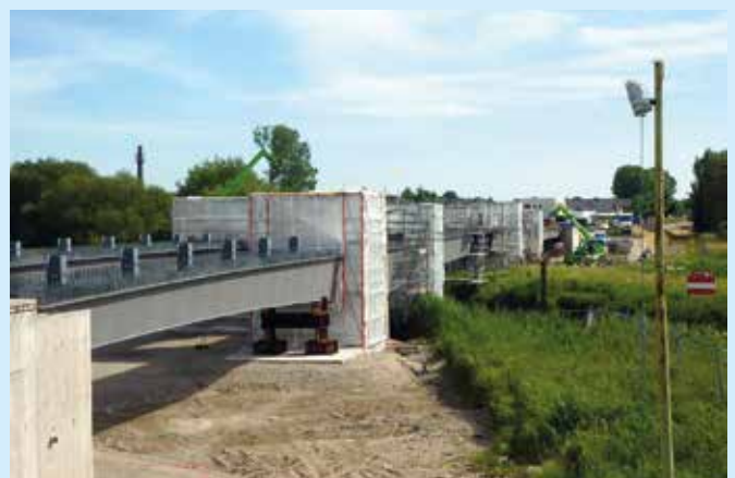
Gesamtansicht Stahlkonstruktion mit Einhausungen der Schweißstöße
