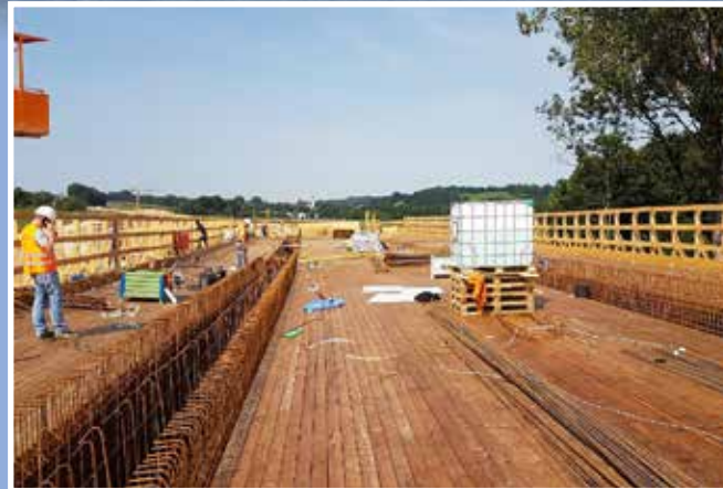
Bewehrung der Spanngliedkanäle und Traversen für die Brücke über den Grimmbach
