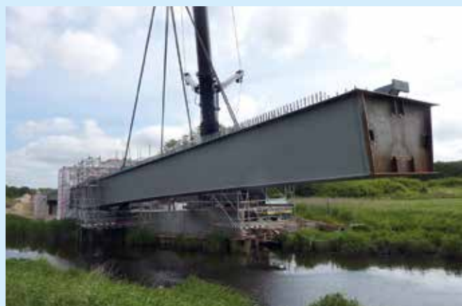
Montage Schuss 105 im Freivorbau
