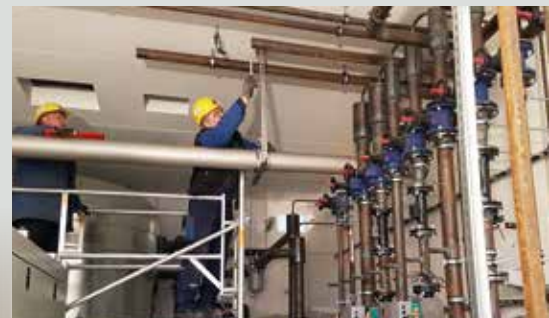
Montage des Heizungssystems im BHKW-Gebäude durch Daniel Schiemenz (links) und Frank Wehrhahn
