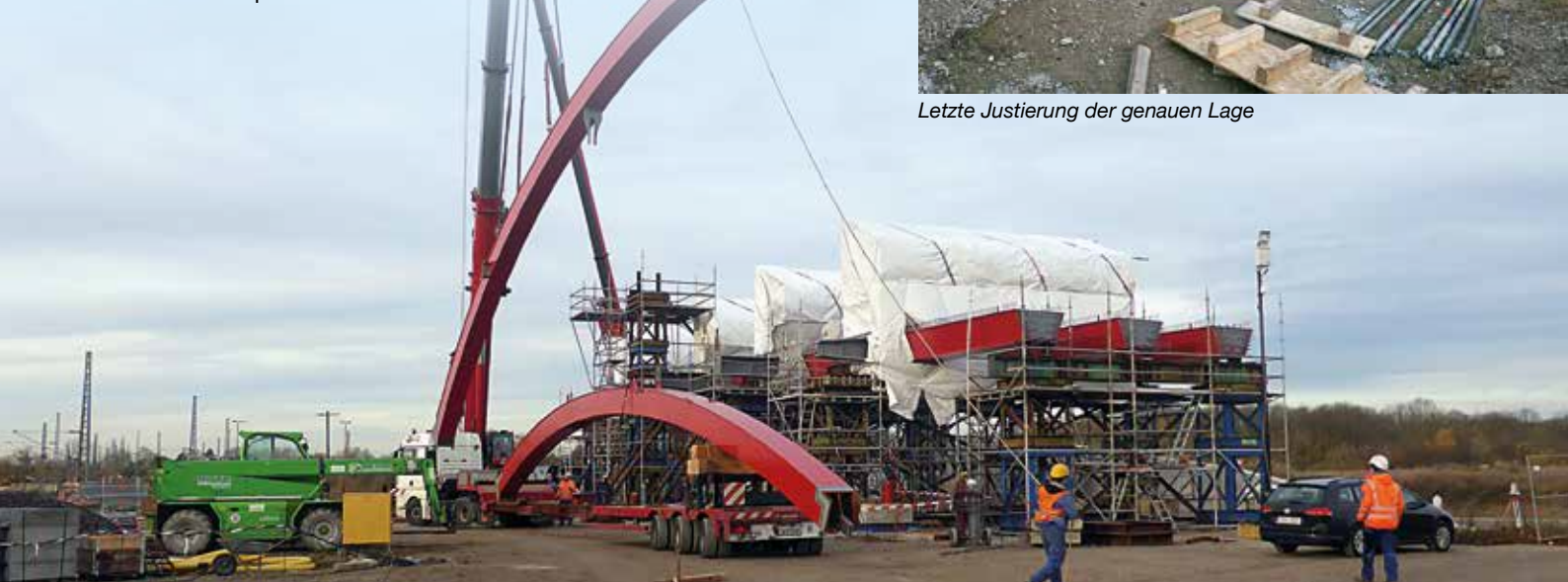
Einhub der Bogenteile
