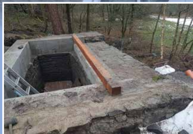
Mit Natursteinen verkleideter Ringanker
