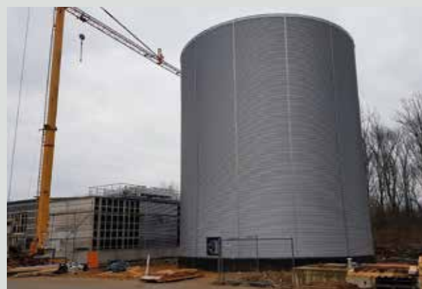
Neuer Faulbehälter der Kläranlage
