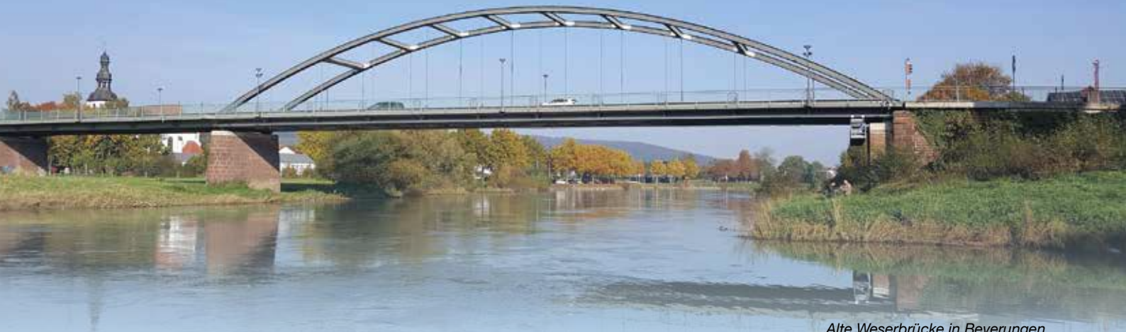
Alte Weserbrücke in Beverungen
