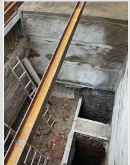
Profil vorgefundener Einhörner Kunst- und Treibeschacht, ausgemauert mit Naturstein Förder- und Fahrungsstrum durch Schachtscheider getrennt
