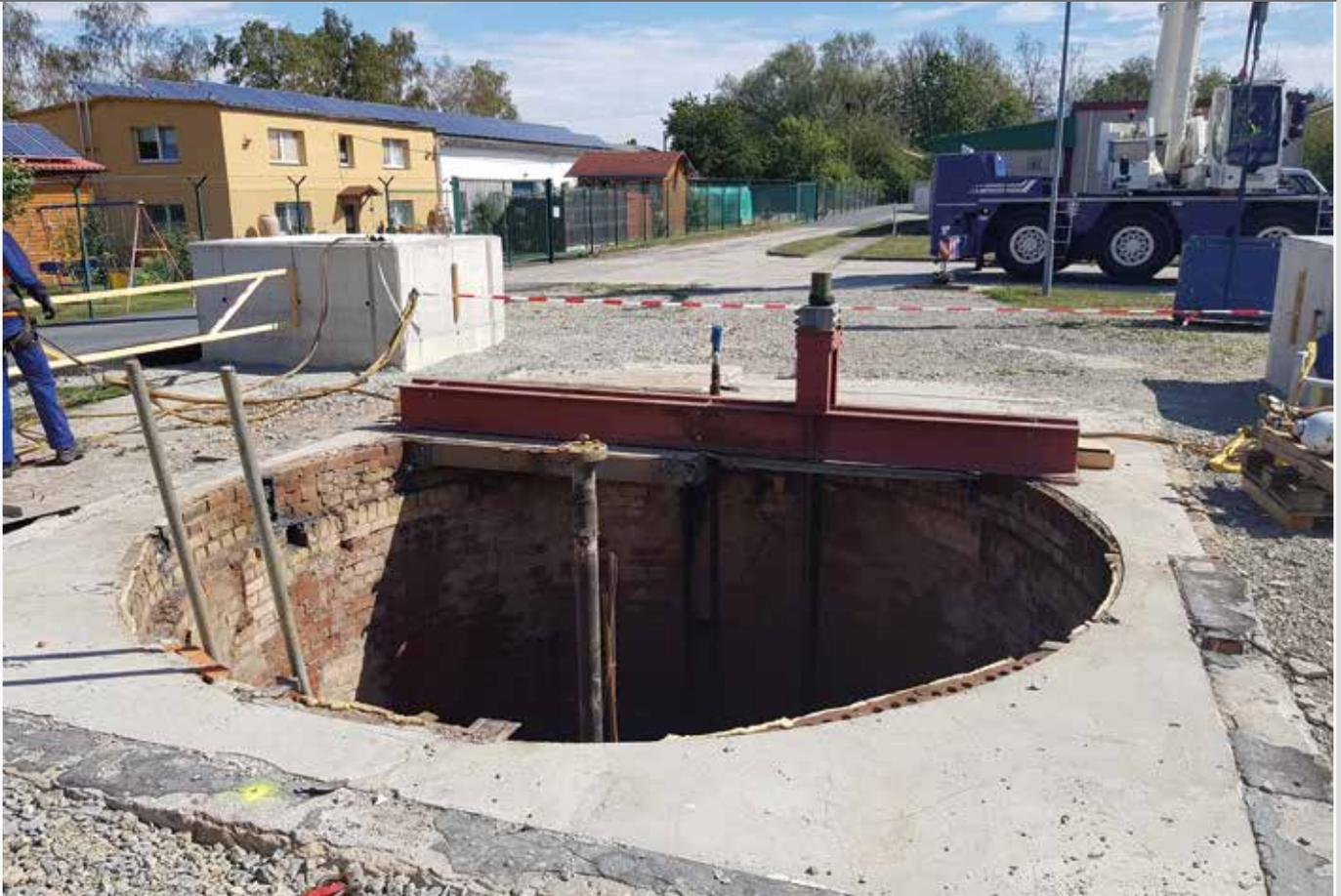
Offener Schacht, Stahlbühnen geräumt, zu sehen ist die auf der Ackersohle aufgehängte API-Leitung in der roten Trägerlage
