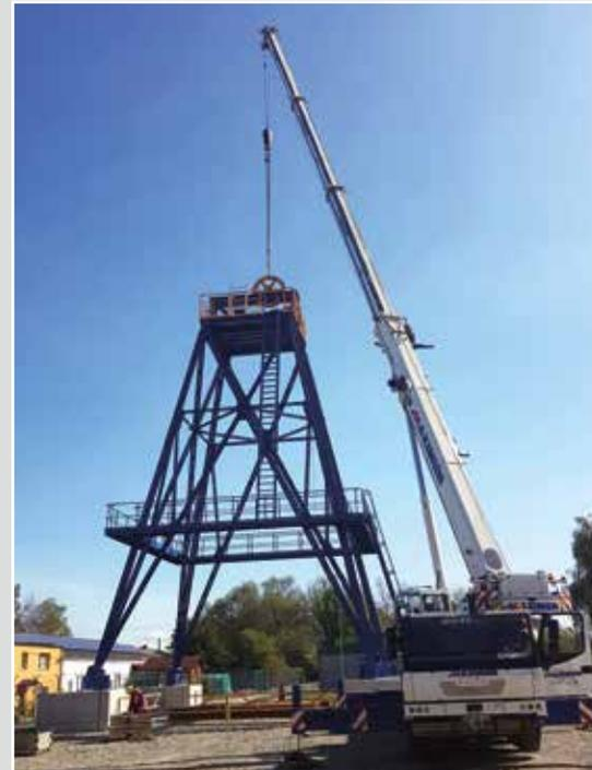
Montage der Seilscheiben auf dem Wetterschachtgerüst
