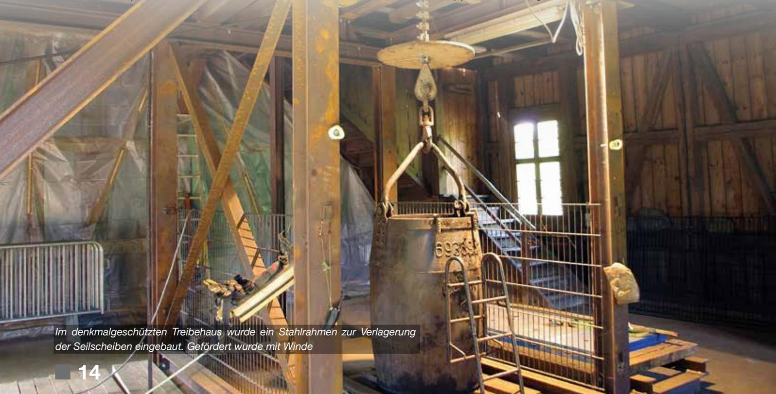
Im denkmalgeschützten Treibhaus wurde ein Stahlrahmen zur Verlagerung der Seilscheiben eingebaut. Gefördert wurde mit Winde
