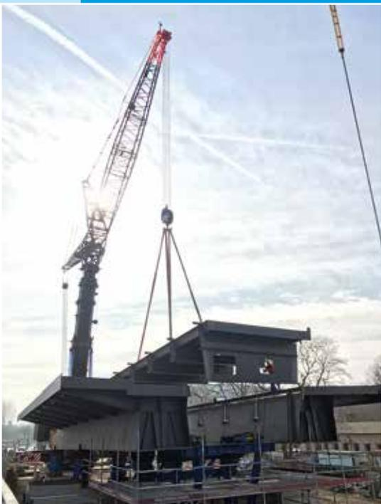
Montage Fahrbahnsegment auf der Vormontagefläche
