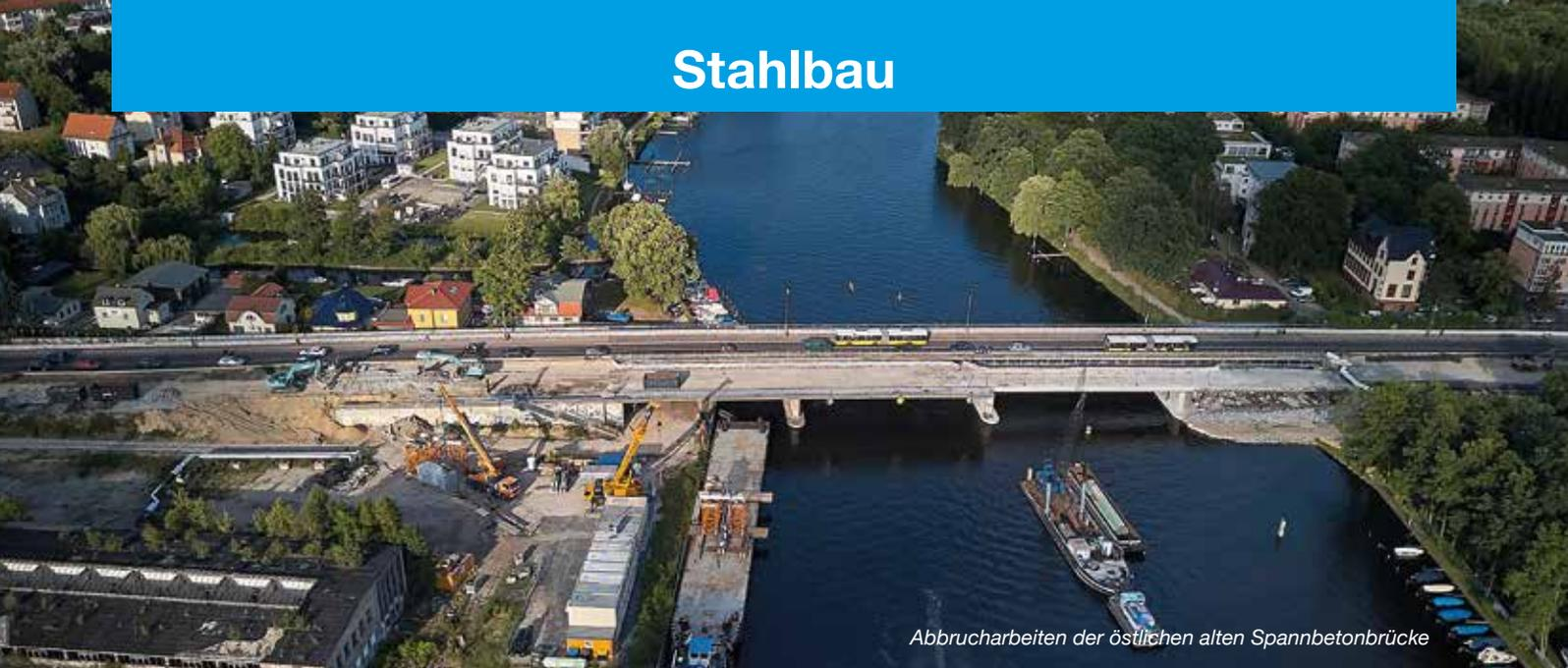
Abbrucharbeiten der östlichen alten Spannbetonbrücke
