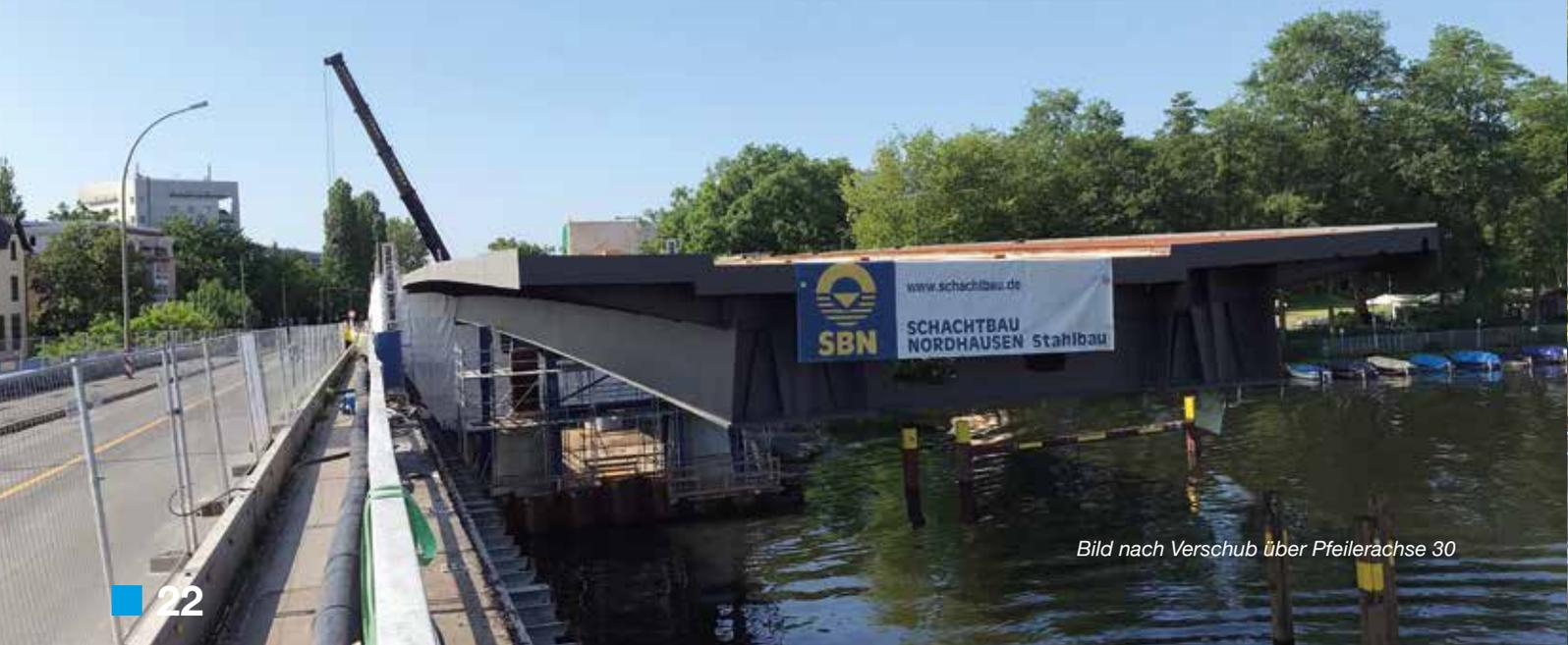
Bild nach Verschub über Pfeilerachse 30
