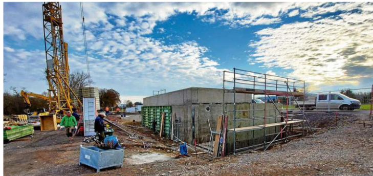
Das ist die Baustelle des künftigen Wasserwerkes in Ellrich.
