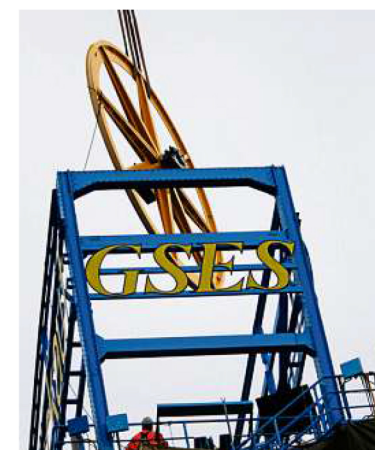
Präzisionsarbeit beim Einfädeln mit dem Kran.
