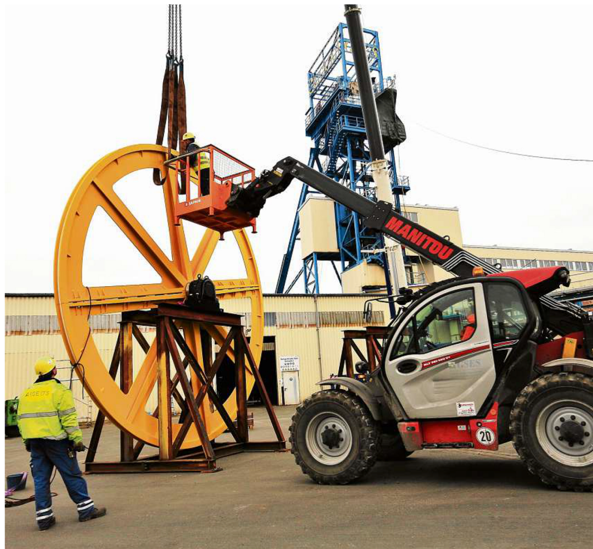
Experten von Schachtbau Nordhausen, Mitarbeiter der GSES und Montagebetreuung von der Firma Steuerer Seilbahnherstellung aus Österreich montierten zwei neue Seilscheiben auf das Fördergerüst. FOTOS (3): HENNING MOST
